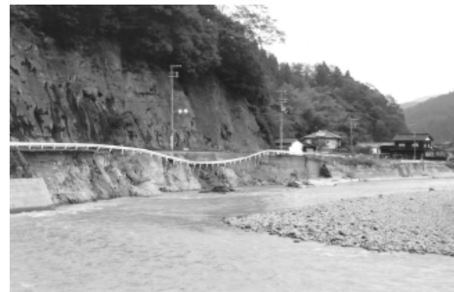
竹野川の増水により崩落した道路（竹野町森本）竹野町提供
