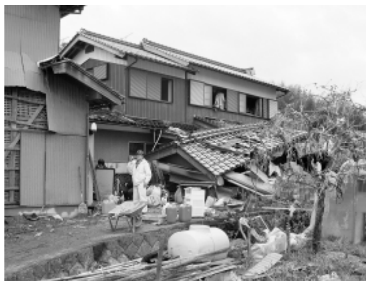
濁流で破壊された民家（赤崎） 日高町提供
