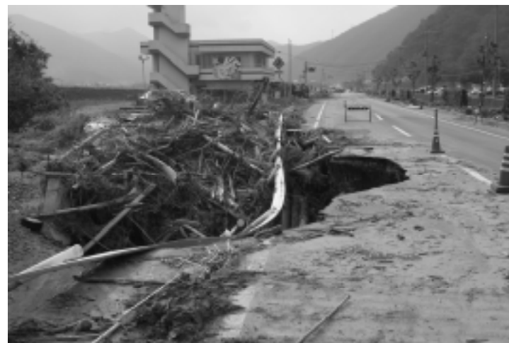
破堤して押し寄せた濁流で駐車場と道路が破壊された出石郡分署 出石町提供
